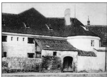
(Půlkruhová bašta, která je dnes připojena k fasádě gymnázia, viz úvodní foto. SOKA Č. Budějovice)
